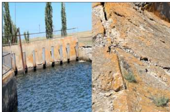
Рисунок 2 – Водозаборное сооружение Палласовской оросительно-обводнительной системы Figure 2 – Water intake structure of the Pallasovskaya irrigation and flood control system
