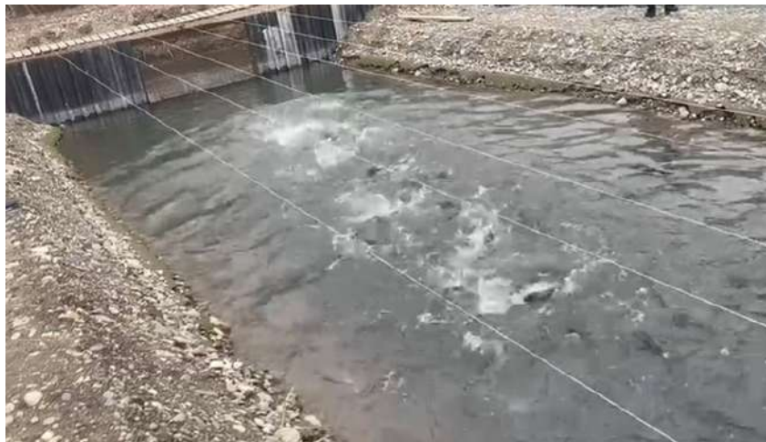
Рисунок 2 – Место исследования. Выращивание радужной форели в бетонных чеках.
