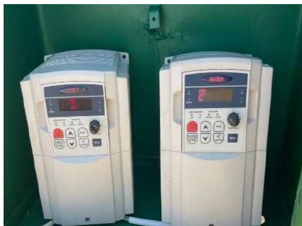
Рисунок 3 – Частотные преобразователи «ВЕСПЕР E2-8300-003H» и «ВЕСПЕР E2-8300-S3L» Figure 3 – Frequency converters VESPER E2-8300-003H and VESPER E2-8300-S3L
