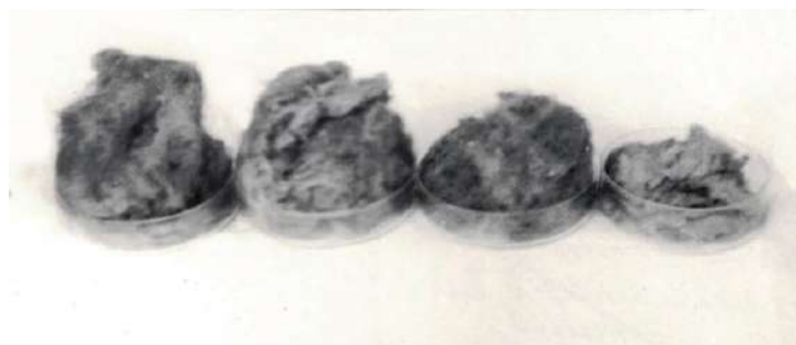
Рисунок 2 – Разрушение утеплителя совмещенного покрытия в процессе эксплуатации животноводческих зданий Figure 2 – Destruction of heat insulation of combined coating during operation of livestock buildings
