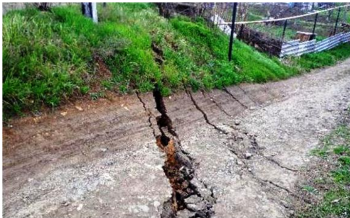
Рисунок 2 – Трещины в земле, образовавшиеся при оползне (фото ГУ МЧС по Ростовской области)
