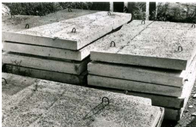
Рисунок 3 – Плиты облицовки каналов мелиоративных систем из бетона на заполнителях Жирновского месторождения
