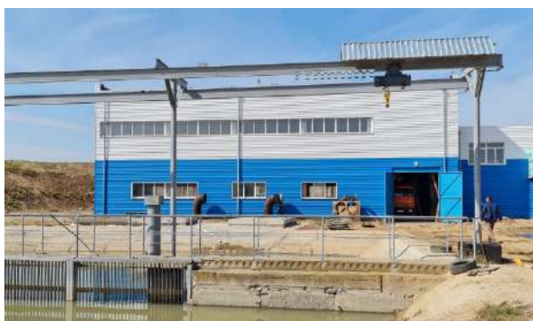
Рисунок 1 – Насосная станция «Родниковская» (общий вид) Фото Трушева В. В. Figure 1 – Pumping station "Rodnikovskaya" (general view) Photo by Trushev V. V.
