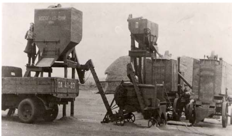
Фото 5 – Агрегат для очистки и сушки зерна с передвижными машинами Photo 5 – Grain cleaning and drying unit with mobile machines
