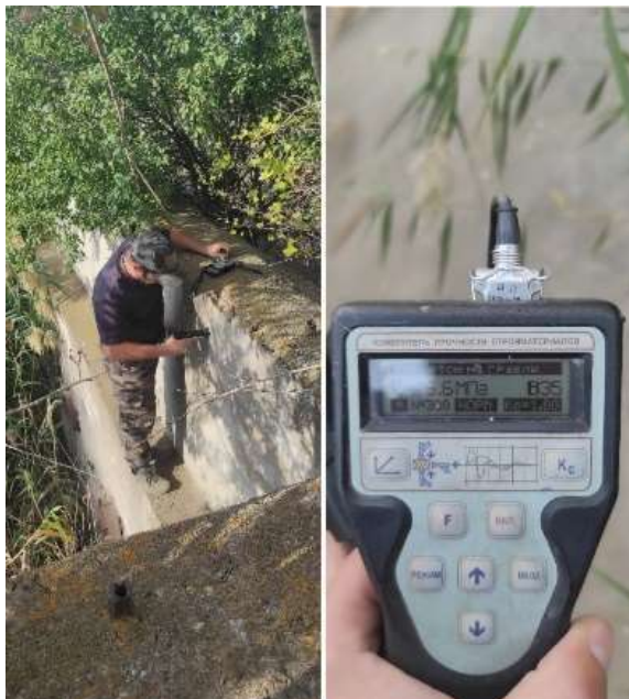
Рисунок 4 – Применение прибора ИПС-МГ4.03 для неразрушающего контроля прочности бетона «Генераловская ОС»
