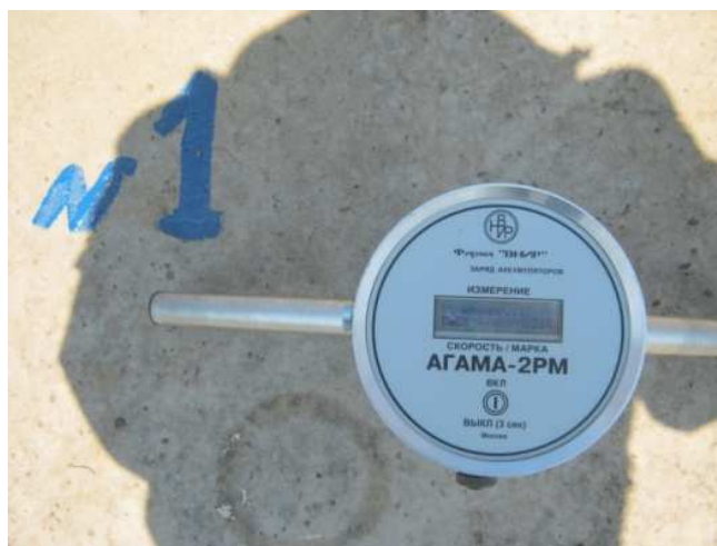
Рисунок 4 – Определение марки бетона по водонепроницаемости с помощью устройства «Агама-2РМ»
