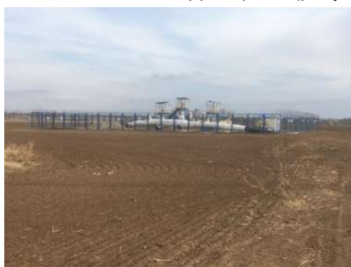
Рисунок 1 – НПС Ростовская область Figure 1 – NPS Rostov region
