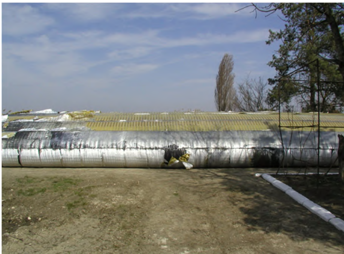
Рисунок 2 – Гибкая дамба, изготовленная по патенту №2291931 заводом «Рассвет» в бассейне Нижней Кубани
