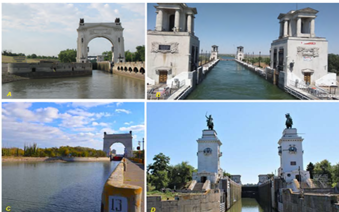
Рисунок 2 – Основные шлюзы Волго-Донского судоходного канала им. В. И. Ленина: А – 1-й шлюз; В – 10-й шлюз; С – 13-й шлюз; Д – 15-й шлюз
