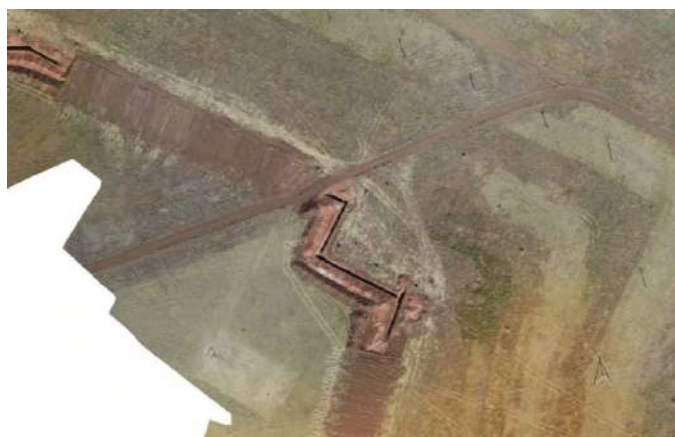
Рисунок 4 – Момент строительно-монтажных работ элемента линейной инфраструктуры для нужд нефтедобычи и начальный этап технической рекультивации (съемка с БПЛА)
