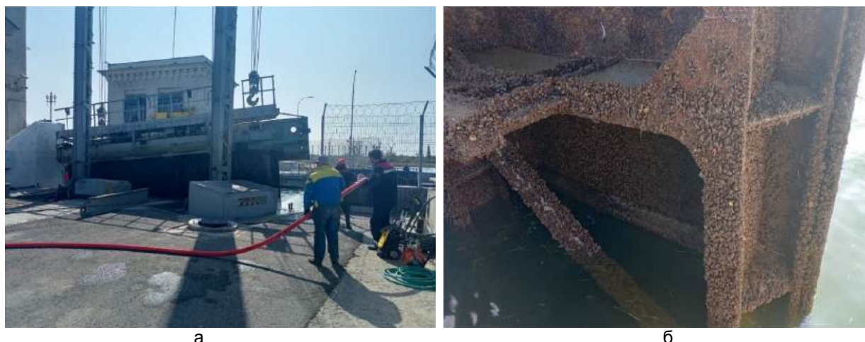
Рисунок 4 – Извлечение створки ворот шлюза № 7 перед отбором проб 4 октября 2023 года (фото авторов, 2023): а – общий вид; б – фрагмент
