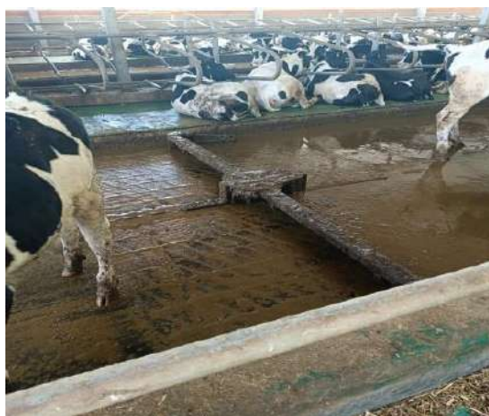
Рисунок 2 – Скребковая система удаления навозной массы
