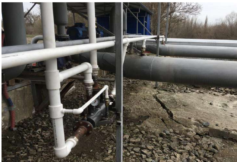
Рисунок 6 – Ввод напорного трубопровода струйного аппарата во всасывающие трубопроводы насосных агрегатов (Общий вид) Figure 6 – Insertion of the pressure line of the jet apparatus into the suction pipelines of pumping units (General view)
