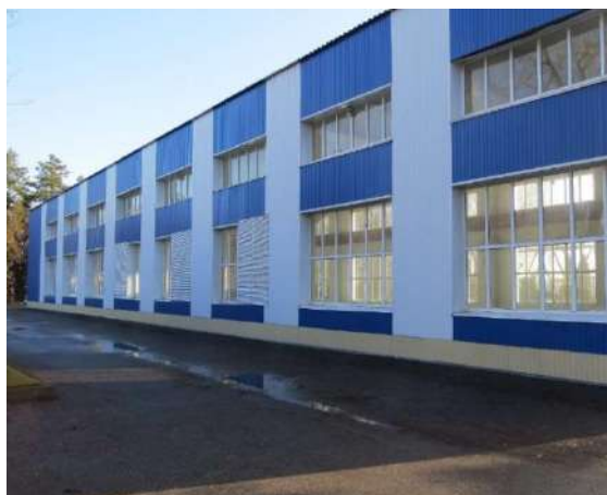
Рисунок 1 – Насосная станция «Междуречье Кубань-Егорлык»
