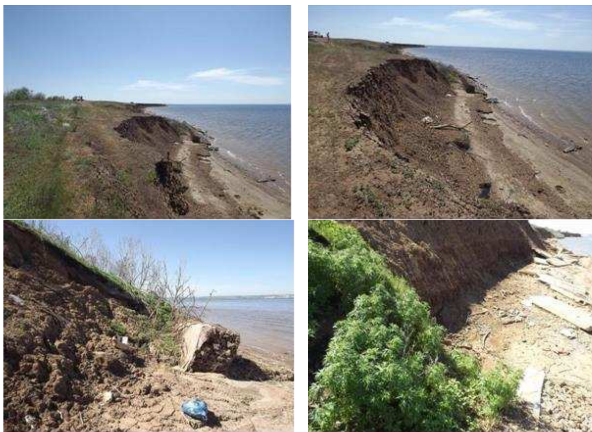
Рисунок 4 - Воронки интенсивного размыва на границе сооружения
