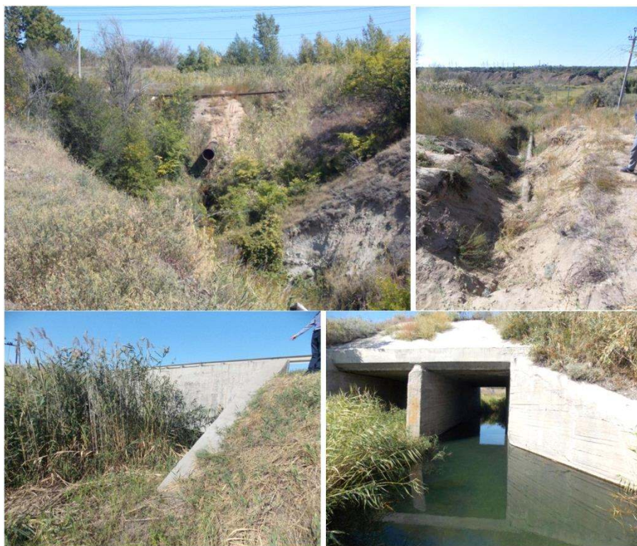
Рисунок 10 – Водовыпуски и водопропускные гидротехнические сооружения
