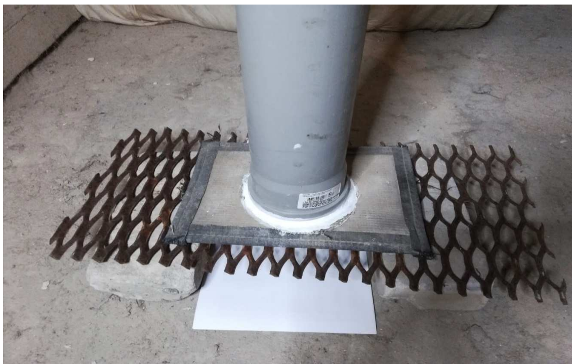
Рисунок 5 – Установка с бетонным полотном
