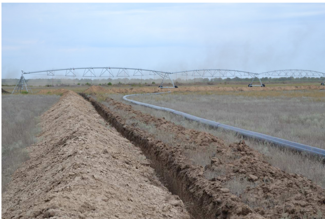
Рисунок 5 – Укладка полиэтиленового трубопровода-водовода в траншею (реконструируемый сегмент Заволжской оросительной системы в АО «Агрофирма «Восток»)
