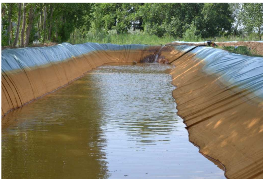
Рисунок 7 – Использование остатков утратившей функции оросительной сети для устройства водонакопителя системы комбинированного орошения
