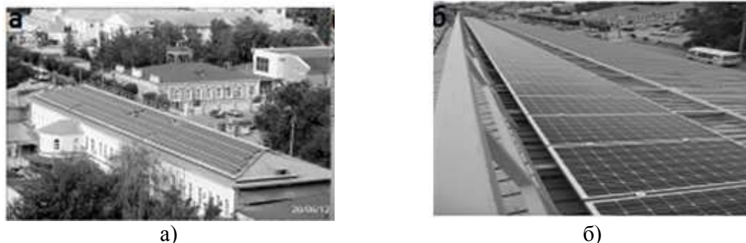
Рисунок 1 – Общий вид здания с размещенной на его крыше фотоэлектростанции (а) и дополнительная секция модулей на северо-западном (обратном) скате крыши (б)
