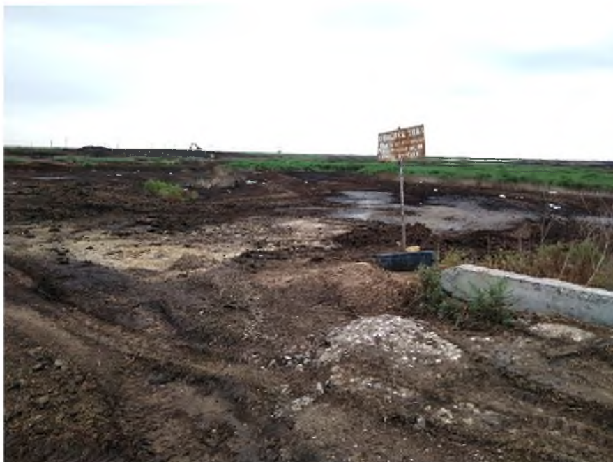
Рисунок 3 – Гидротехническое сооружение: пруд-накопитель сточных вод ЗАО «Птицефабрика «Волжская» Среднеахтубинского района Волгоградской области
