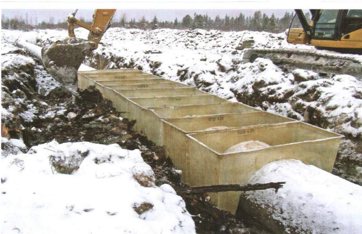
Рис. 5.2. Пригружение нефтепровода
