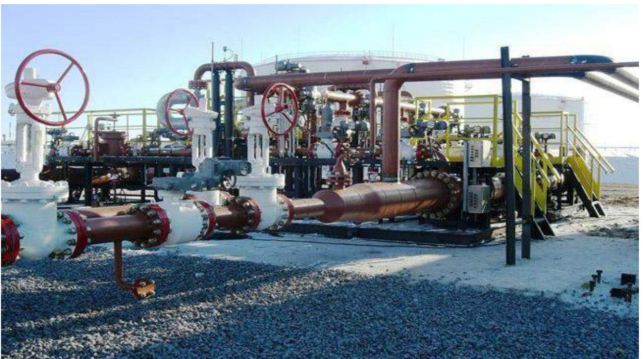
Рис . 4.6. Два варианта узлов учета товарной нефти
