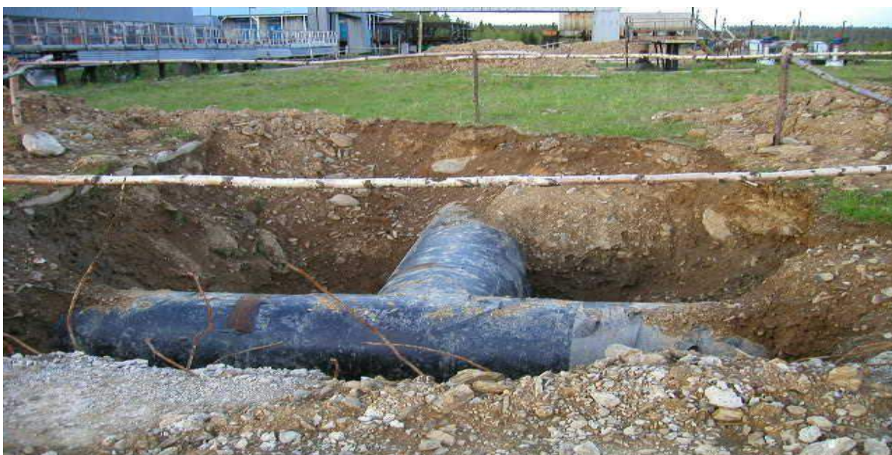
Рис.1.3. Подземная укладка нефтепроводов, соединение двух трубопроводов одинакового
