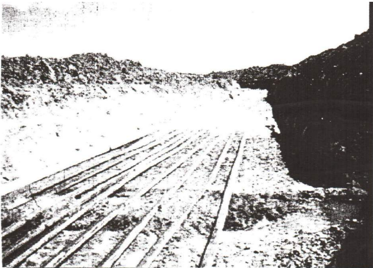
Рис. 5.1. Укладка нефтепроводов в одну траншею
