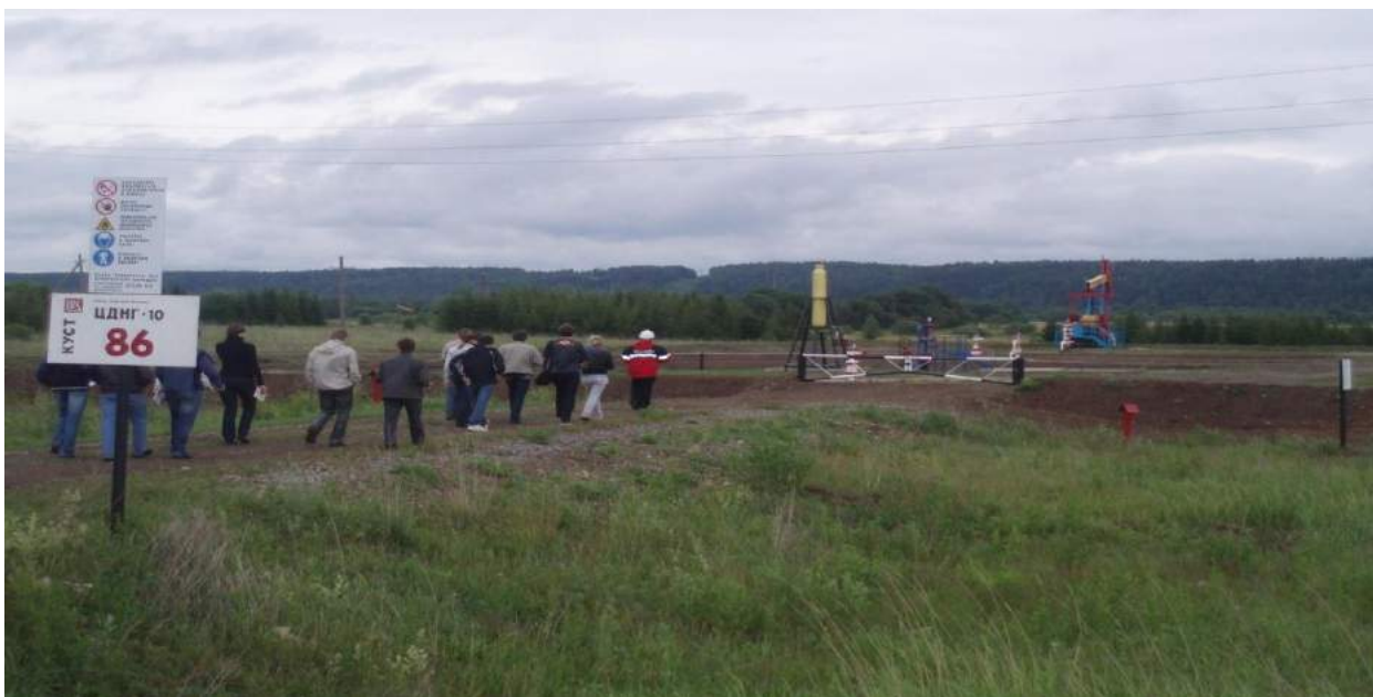
Рис. 1.2. Куст скважин. Станок – качалка, газовая, нагнетательная скважины
