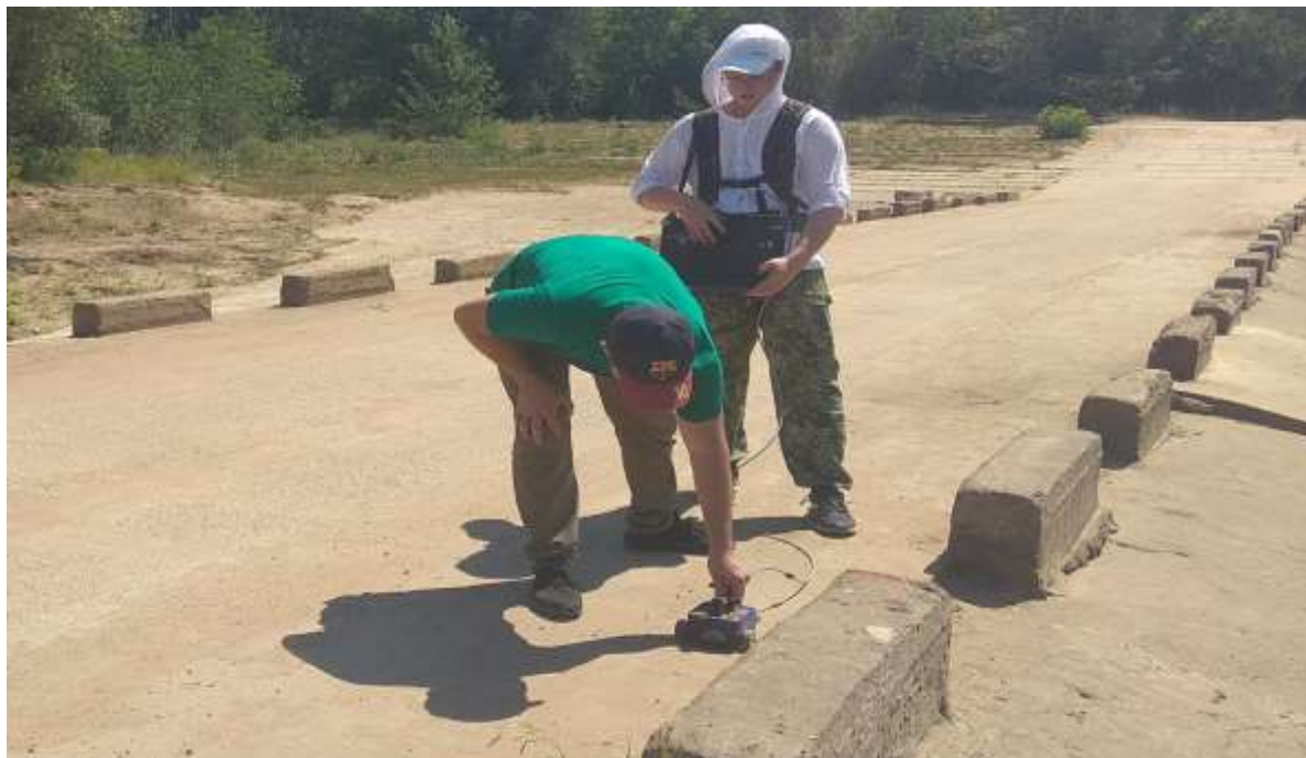
Рисунок 3 – Сканирование плотины бетоноскопом АБ-1700 Figure 3 – Scan of the dam with the AB-1700 concrete scope
